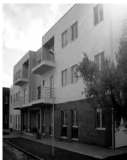
LA SEDE CENTRALE DELL'ARPACAL
