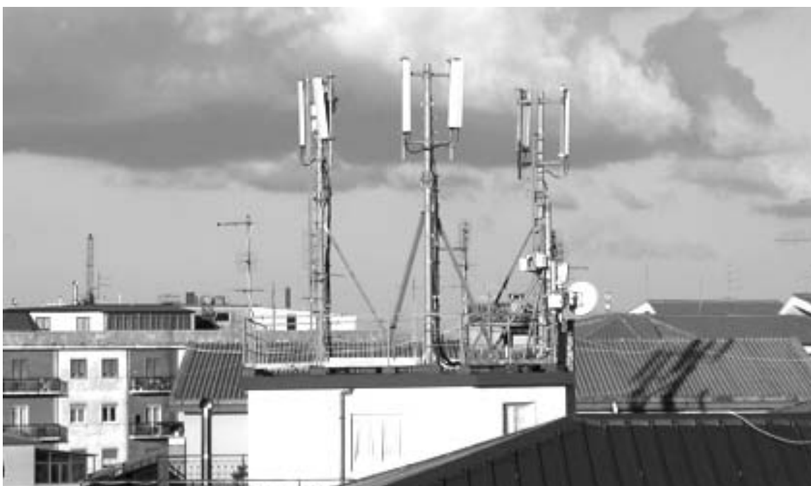
Fig. 1 Una Stazione radio base per telefonia cellulare
